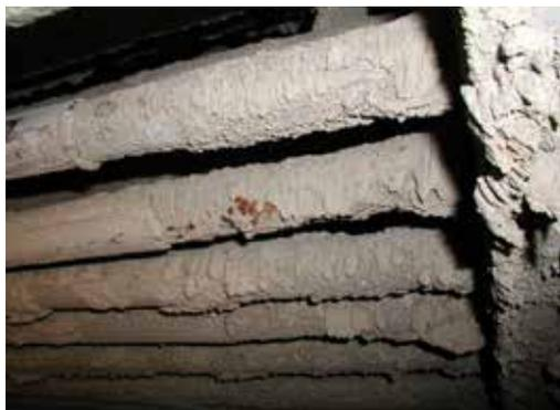
**FIGURA 2 - Depositi di ceneri sulle superfici dei tubi di scambio di un impianto termico**
